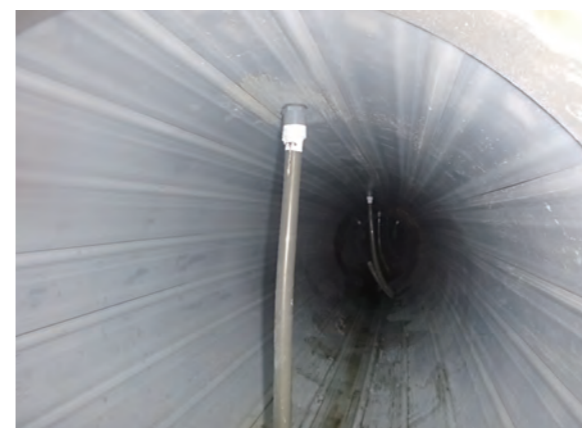
管内充てん材注入
