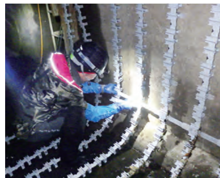
補強リング設置
