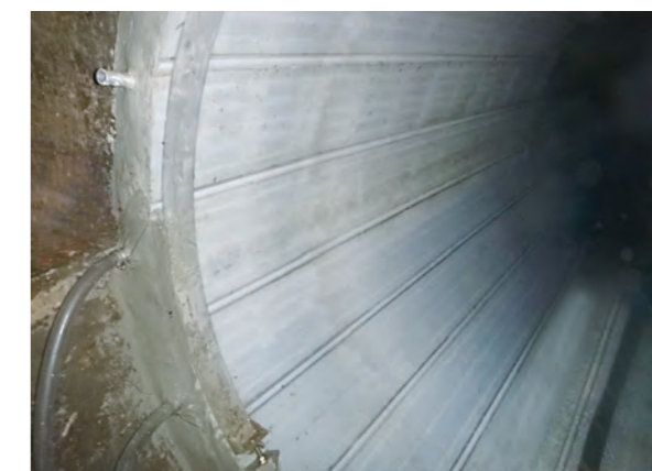
管口充てん材注入
