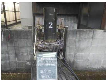
鋼管据付完了
