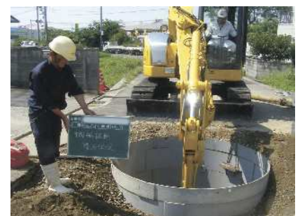
ケーシング建込完了
