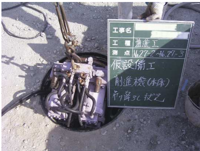
削進機 マンホール内吊り降し状況
