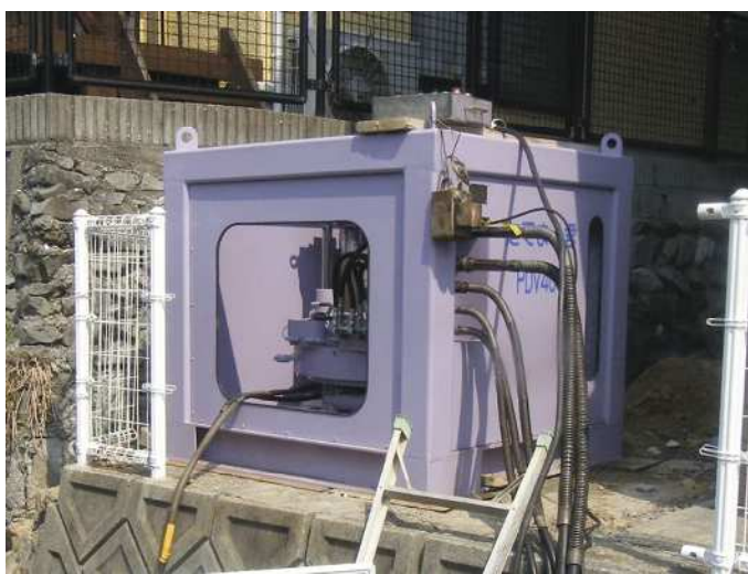
たて掘削機 据付状況
