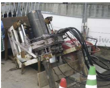
斜坑削進状況
