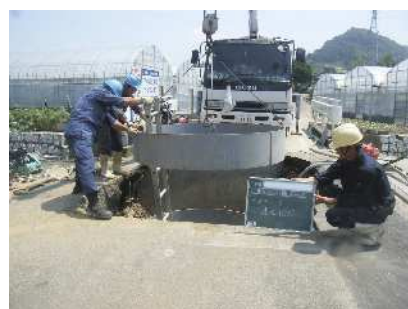
先端ケーシング内掘削状況
