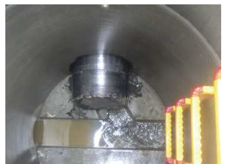
既設人孔到達状況
