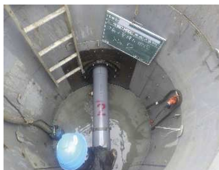
塩ビ管挿入状況
