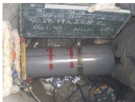
マンホール内塩ビ管挿入状況
