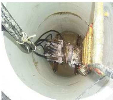
削進機 マンホール内設置状況
