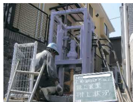
排土装置排土状況
