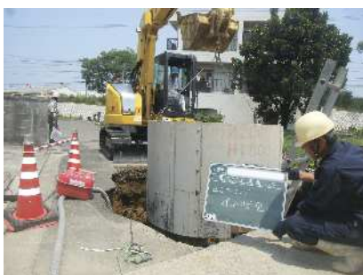
中間ケーシング建込状況
