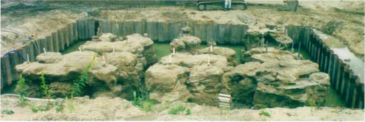
野外注入試験における掘削調査状況
