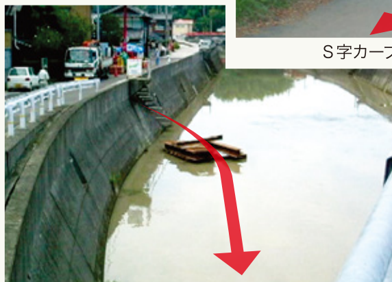
河川を横断する施工
