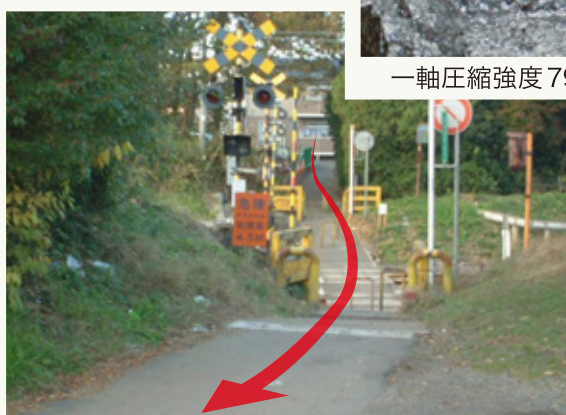
S字カーブ・軌道の下越し施工
