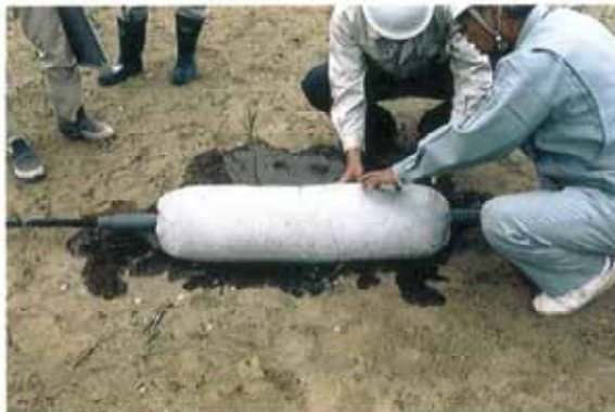
ジオバッグにジオバックグラウトを充填した注入外管
