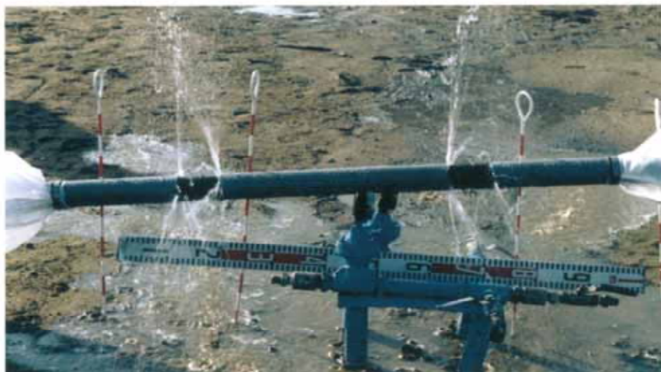
注入外管の多段注入口からの同時注入状況
