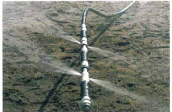
注入内管からの噴射状況
