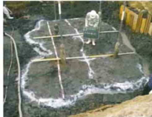
↓パーマロック・ASF-IIを用いたエキスパッカ工法による浸透固結状況
